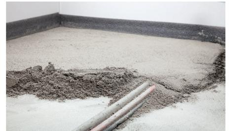
**6** Auf dem Rohboden befindliche Rohre/Kabel werden mit eingearbeitet oder entsprechend angearbeitet.
