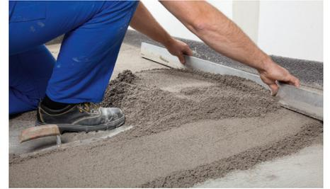
**3** Material mit Glättkelle verdichten und Abziehleisten mittels Wasserwaage und Abziehlatte einrichten.
