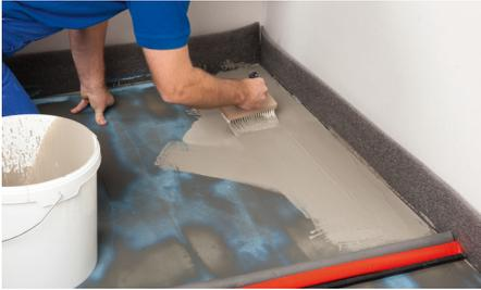
**1** An aufsteigenden Bauteilen sind Randdämmstreifen anzubringen. Haftbrücke, hergestellt aus Bindemittel und Wasser mit Quast, Bürste oder Besen, satt auf den zuvor grundierten Untergrund auftragen.
